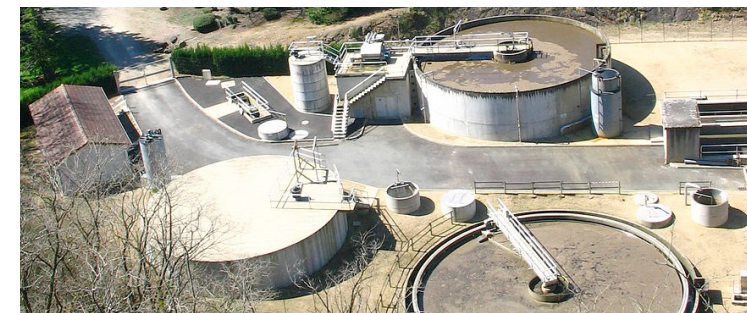
Bassins de décantation de la station d'épuration de Nérès-les-Bains (Allier). En France, la plupart des eaux usées subissent ce type de traitement, au cours duquel certains nutriments sont concentrés dans des boues d'épuration, tandis que d'autres sont volatilisés ou rejetés dans le milieu naturel. Crédits : Toucassé, CC BY-SA, Wikimedia Commons.
